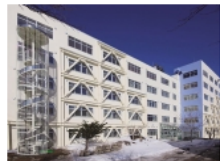
耐震工事済施設（札幌市児童診療センター）
