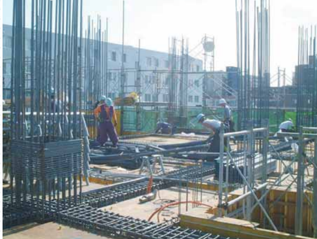
5 主組立て・帯筋巻きで、カゴ状柱組立て
