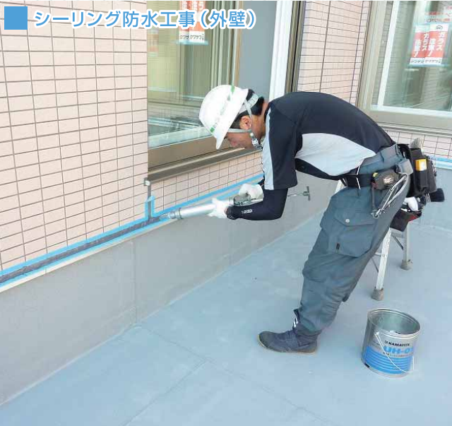
■ シーリング防水仕上げ工事 (外壁)
