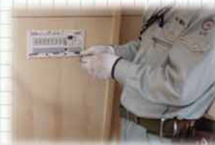
屋内配線工事
