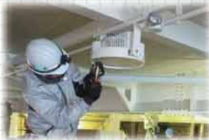
屋内配線工事
