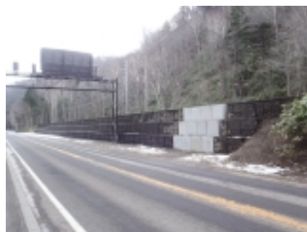
土石流防止柵工事
