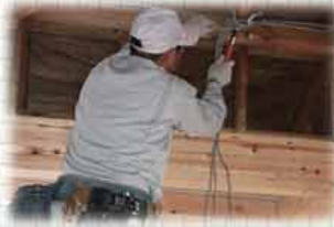
屋内配線工事
