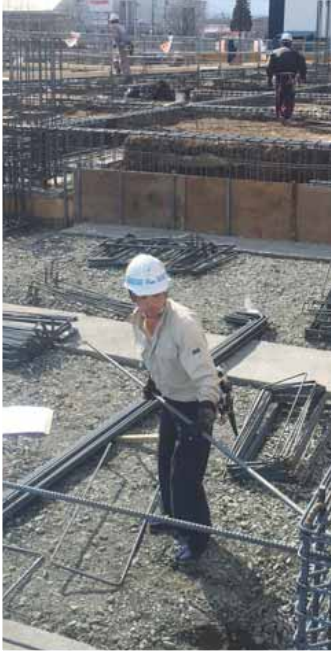
5 主組立て・帯筋巻きで、カゴ状柱組立て
