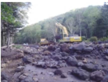
災害復旧工事（土石除去）
