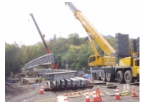
災害復旧工事（仮橋設置）
