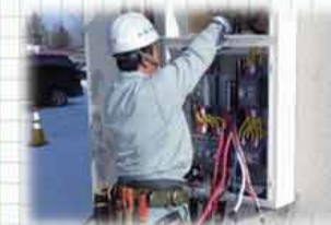
屋内配線工事
