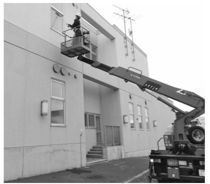
高所作業車を活用し、2階部分の汚れも拭き取った
